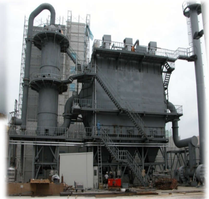
靜電集塵設備(EP)
